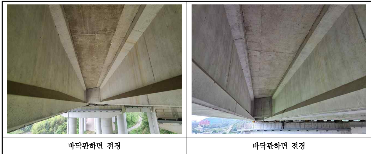
【사진 41.3.2】 바닥판하면 전경
