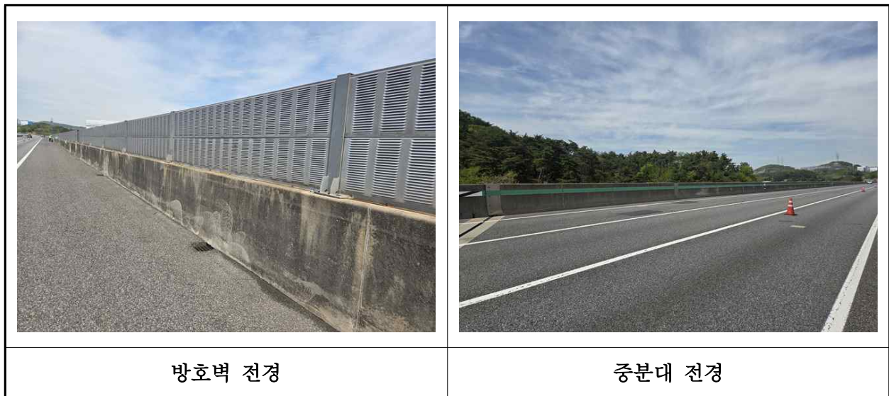
【사진 41.3.24】 방호벽 및 중분대 전경
