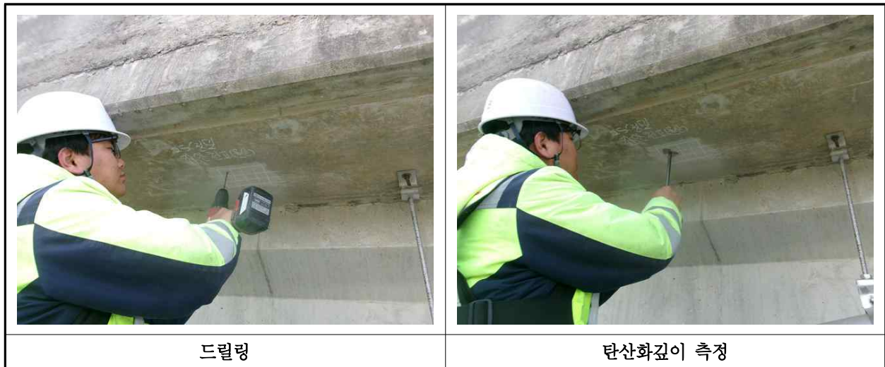
【사진 41.4.3】 탄산화 깊이 측정 현장사진
