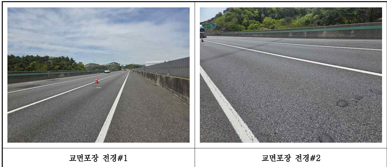
【사진 41.3.20】 교면포장 전경
