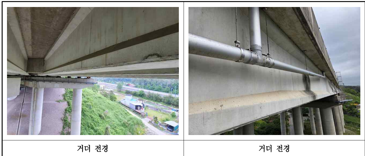
【사진 41.3.4】 거더 전경
