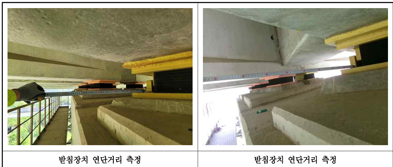
【사진 41.3.15】 교량받침장치 연단거리측정
