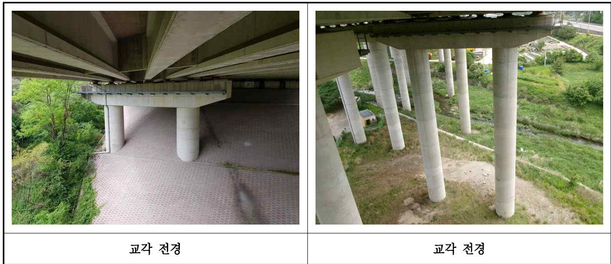
【사진 41.3.10】 교각 전경
