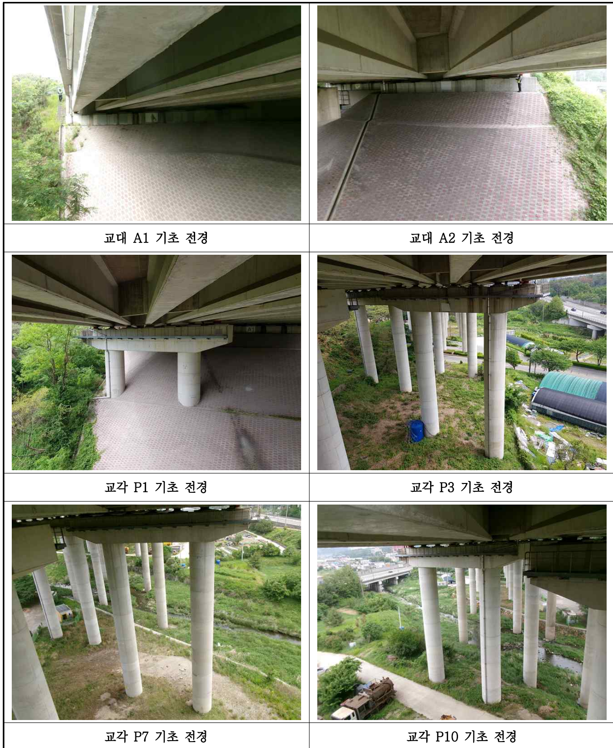
【사진 41.3.12】 기초 전경
