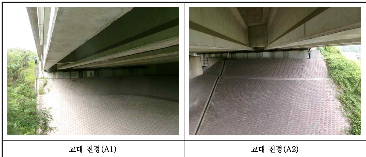
【사진 41.3.8】 교대 전경
