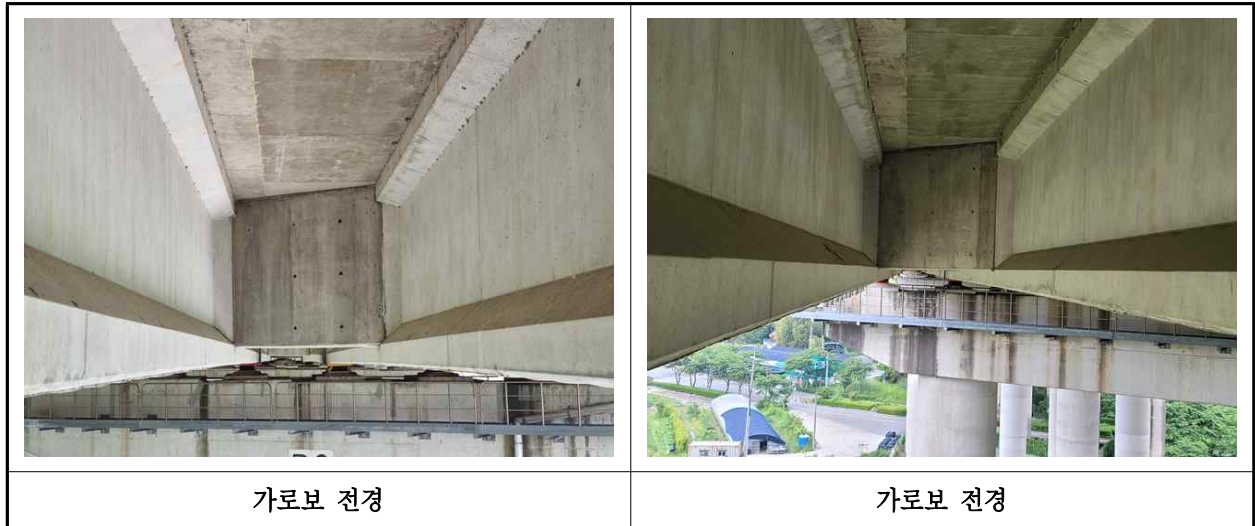
【사진 41.3.6】 가로보 전경
