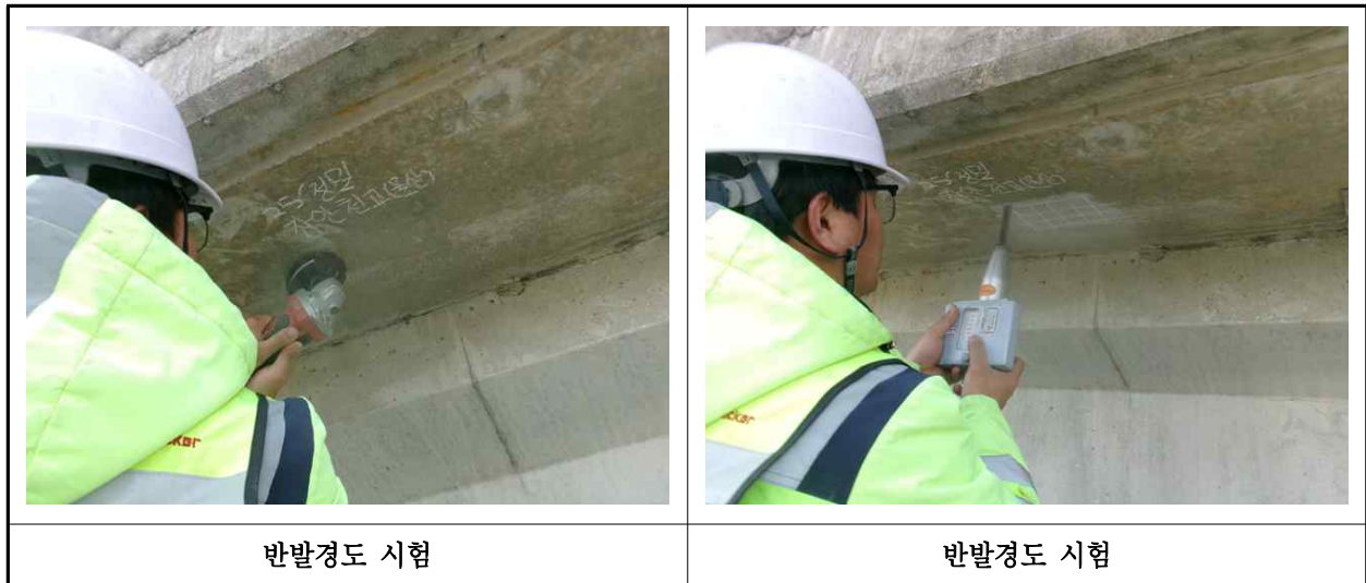
【사진 41.4.2】반발경도시험 현장사진
