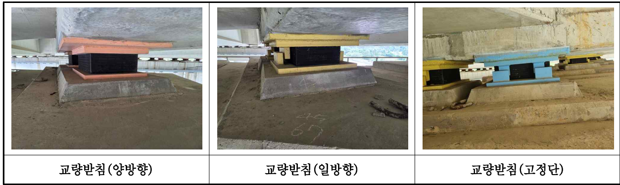
【사진 41.3.13】 교량받침 전경
