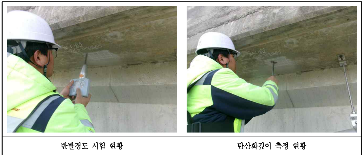
【사진 41.4.1】 콘크리트 내구성조사 현황
