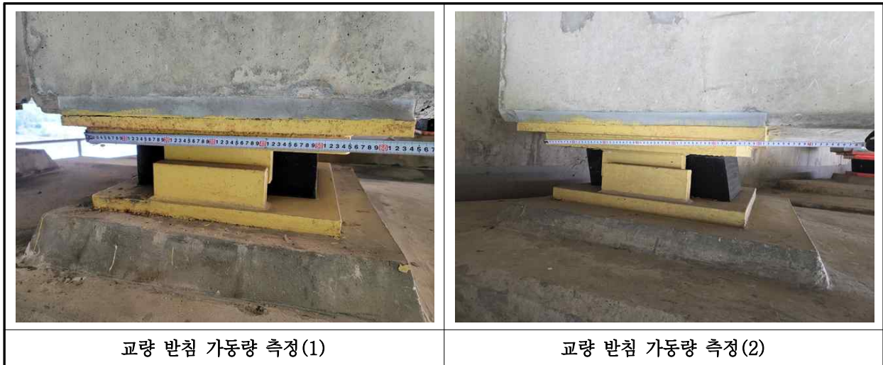
【사진 41.3.16】 교량받침 이동량 측정
