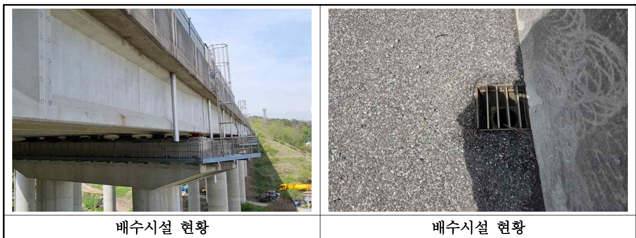
【사진 41.3.22】 배수시설 전경
